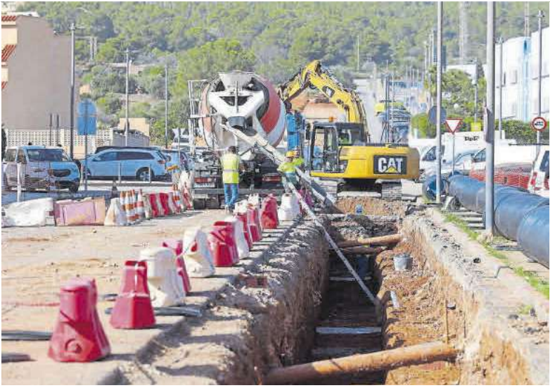
Tendido de canalizaciones en la calle Aubarca, en la zona de Can Misses, junto a la sede de Diario de Ibiza.
